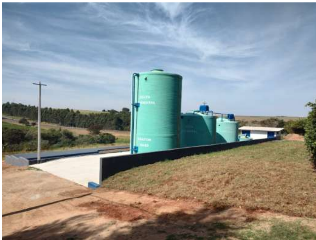
Figura 6. Vista da ETE do Distrito de Nova América.
