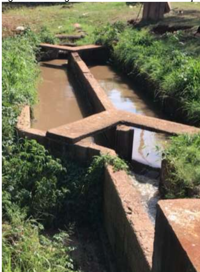
Figura 4. Vista geral dos canais de desarenação
