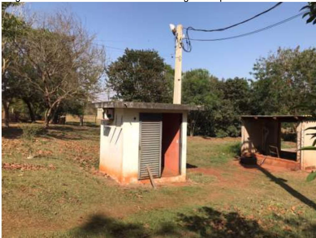
Figura 8. Vista do local do nicho de abrigo dos quadros de comando.
