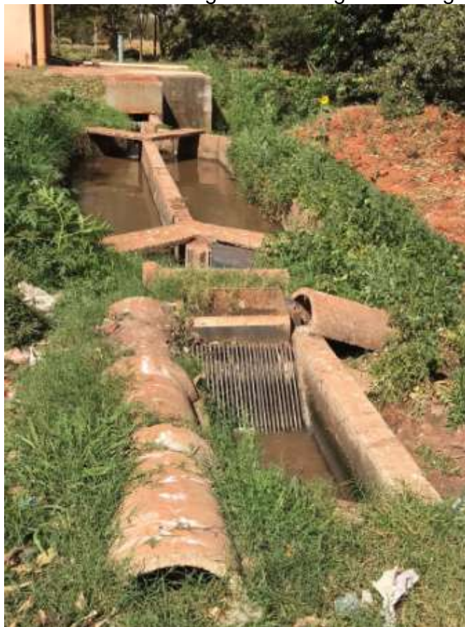
Figura 3. Vista do canal da grade na chegada do esgoto bruto
