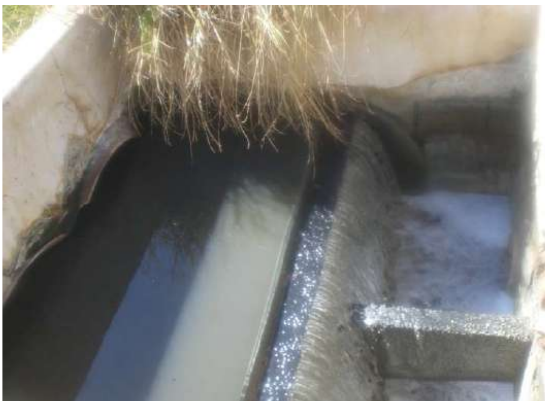
Figura 7. Caixa de distribuição de fluxo na entrada da primeira lagoa facultativa.
