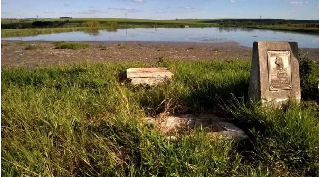
Figura 3. Vista da região de entrada da lagoa anaeróbia com sua caixa de alimentação.
