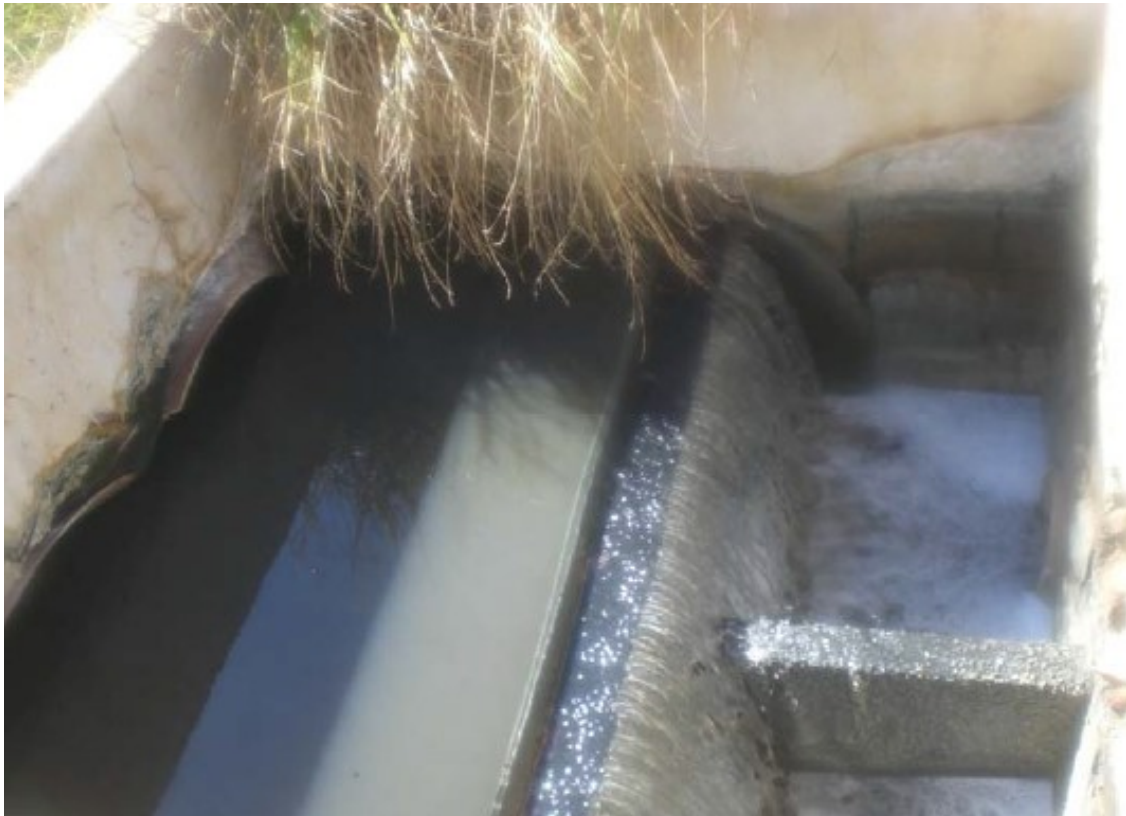
Figura 6. Caixa de distribuição de fluxo na entrada da primeira lagoa facultativa.
