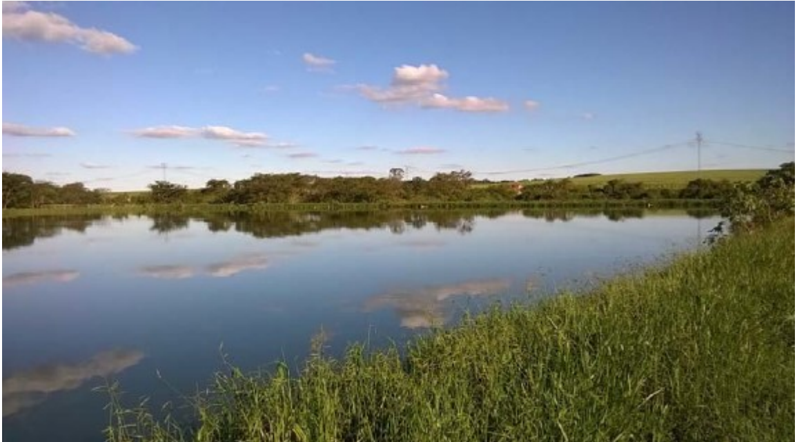
Figura 5. Vista global da segunda lagoa facultativa. Ao fundo observam-se as estruturas de coleta de efluente.
