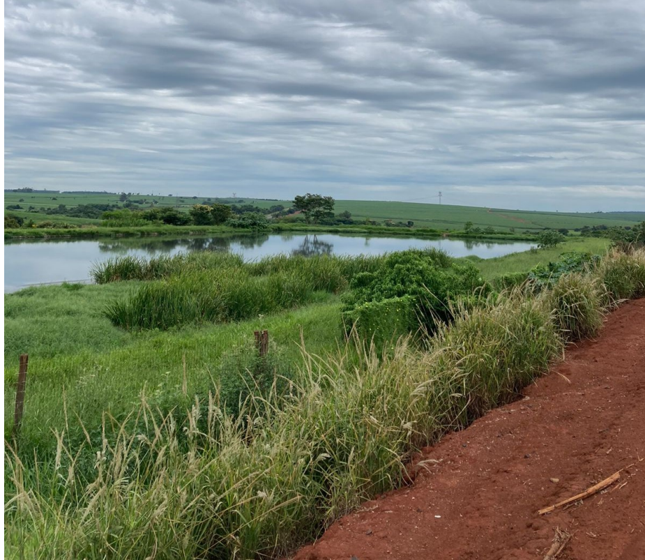
Figura 9. Vegetação do entorno da ETE do Município.
